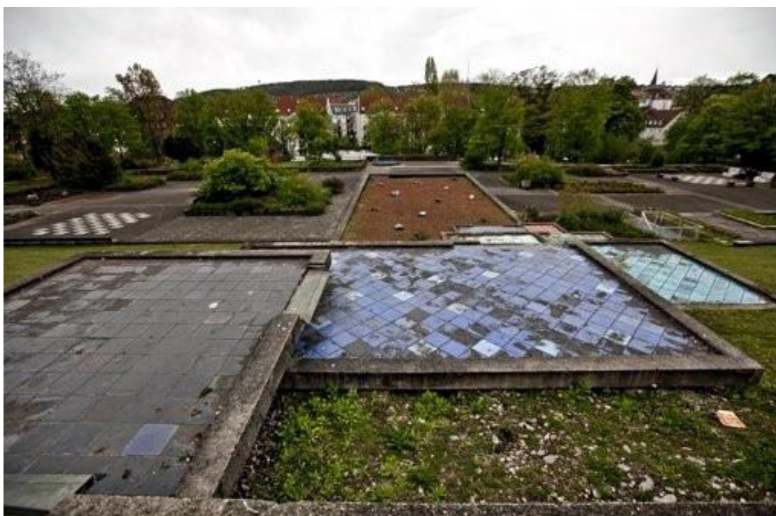
Wasserbecken, Hochbeete, Spielfelder Südseite Park Villa Berg
