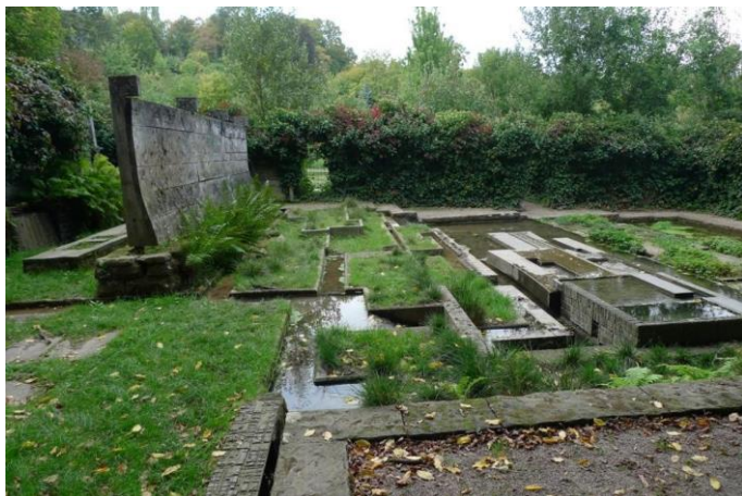
Memorial Garden vor der Sanierung
