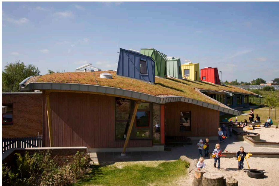
Dachbegrünung einer KiTa im Technologiepark in Bremen
