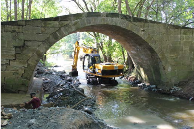
SANIERUNG DER HISTORISCHEN SANDSTEINBRÜCKE
