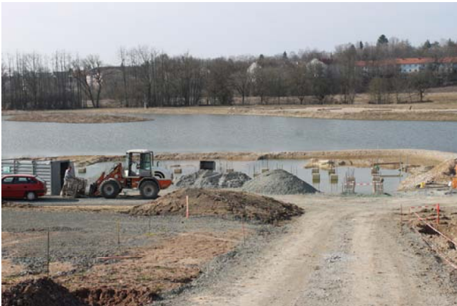
FUNDAMENTARBEITEN AM NEU GESCHAFFENEN HAMMERSTÄTTER SEE
