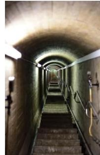
technischen Kontrolle der Talsperre ist am Grunde des 50-Meter-Betonbaus ein unterirdischer Gang eingezogen, von beiden Seiten durch Treppen erreichbar – knapp 200 Stufen in die Tiefe, knapp 200 Stufen bis zurück zur Oberfläche, das war ein eindrucksvoller Anblick (und eine sportliche Herausforderung!).
