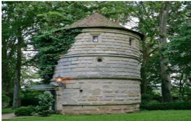
Turm im Schlosspark, Reste der Befestigungsanlagen
