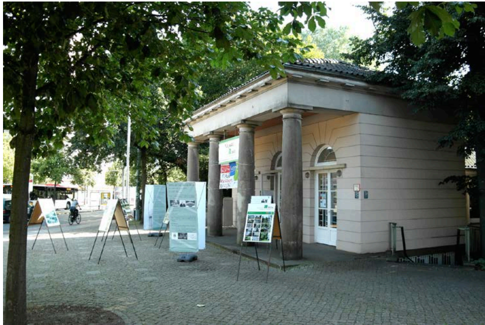
DGGL-INFO-Center Bremen, Bürgermeister-Smidt-Straße 88 (Wallanlagen)
