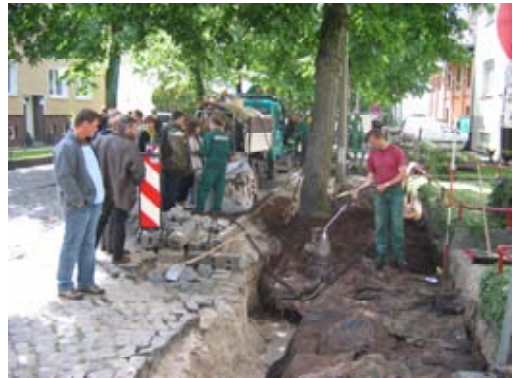
Vorführung der Standortverbesserung und Gehwegsanierung bei Altbäumen in der Laakstraße
