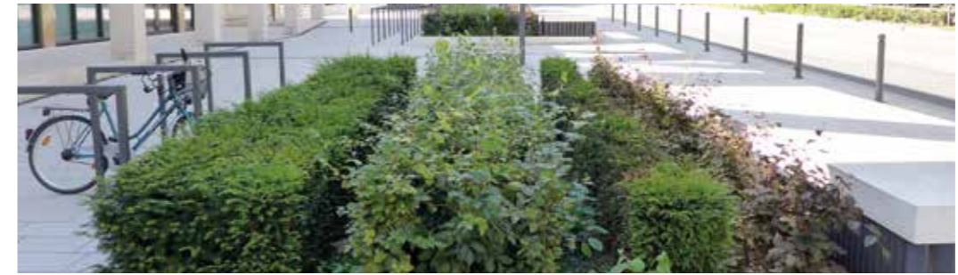
◀ Heckenbänder an den Tiefgaragen Entlüftungen im Osten
