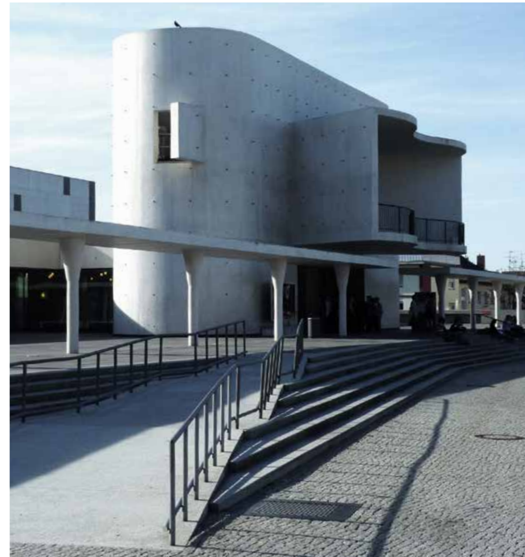
◀ Das neue Eingangsbauwerk in Form eines Lautsprechers
