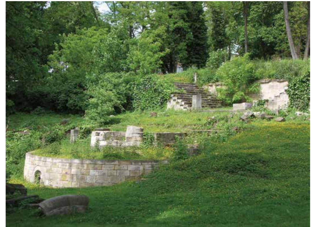
◀ Die historische, im Krieg zerstörte Brunnenanlage vor der Sanierung
