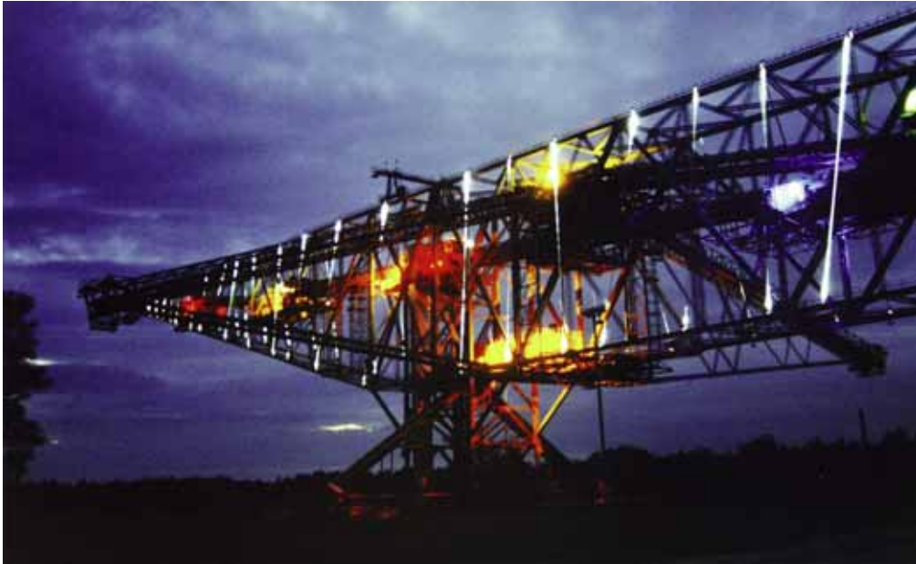
Besucherbergwerk F60 in Lichterfeld
