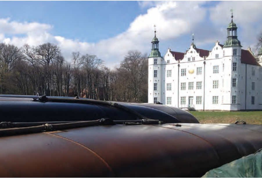
Geotubes Grabensanierung
