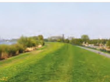
Blick vom Deich auf die Filterbecken
