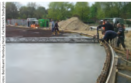
Betonieren der geeigneten Beckensohle
