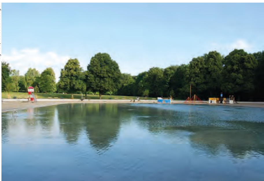
Das Becken nach der Fertigstellung
