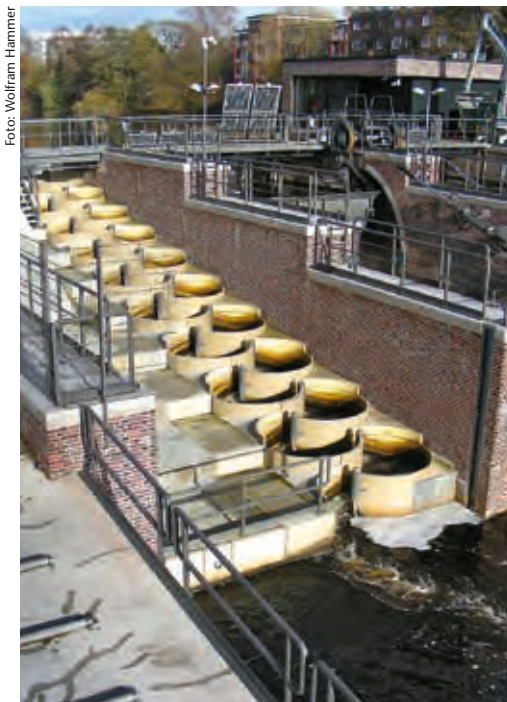
Mäanderfischpass an der ehemaligen Fuhlsbüttler Schleuse in Bau 2013
