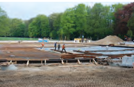
Einbau der Bewehrung – deutlich sind die Einlaufkästen zu erkennen.
