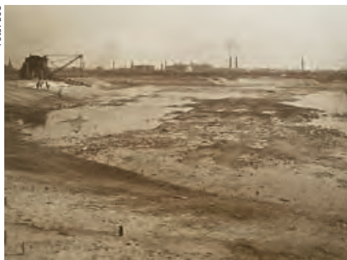
Ausbaggern des Stadtparksees vor über 100 Jahren
