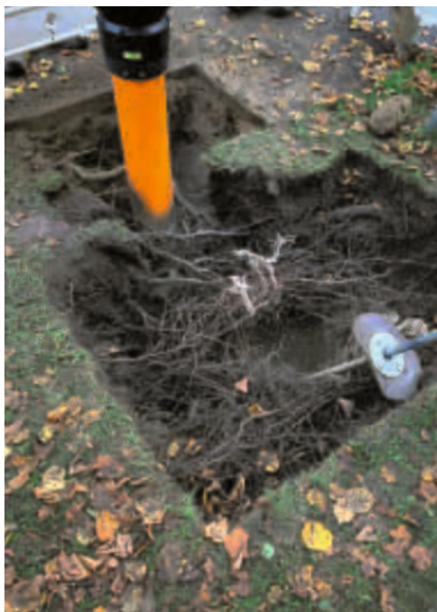
Saugbaggereinsatz – schonendes Freilegen von Wurzelwerk.
